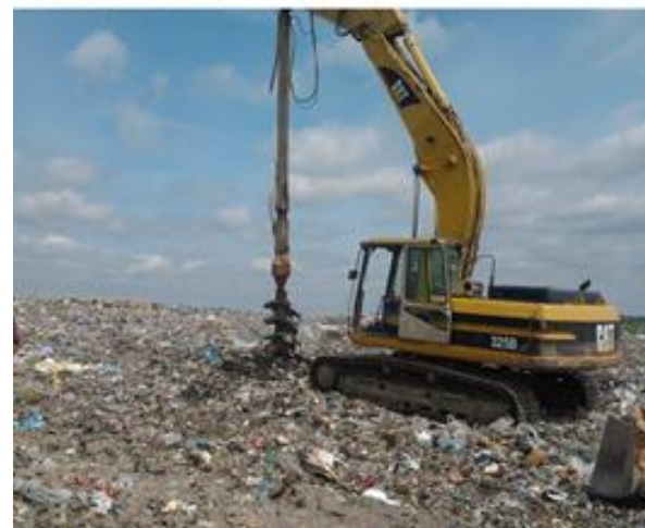
7. ábra: Furatok készítése a depóniában.
